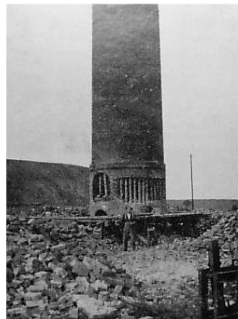
Abb. 28: Die Abstützung des Schornsteins. (= Original-Bildunterschrift)
