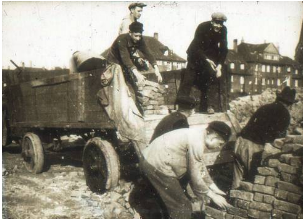
Abb. 39: Abbruch der Ziegelei Teimann. Verladen der Steine.
