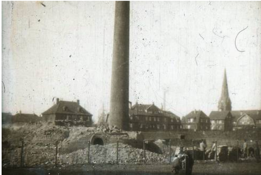
Abb. 37: Abbruch der Ziegelei Teimann. Im Hintergrund Häuser an der Straße Auf der Kiekbast und der Turm der evangelischen Kirche.
