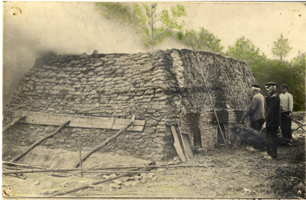
Abb. 4: Feldbrandofen in Vreden
