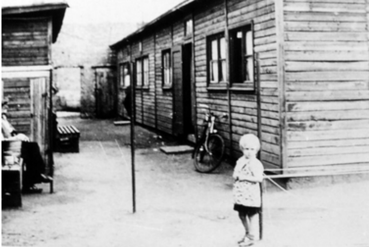
Abb. 21: Teilansicht des Lagers Ewald an der Limbeckstraße
